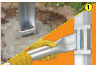
1 Cimentar poste / colocar poste de apoyo.
